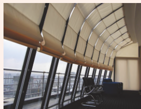
Daylighting Control 采光控制
